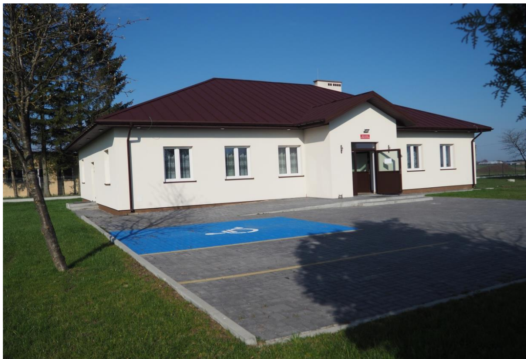
Wybudowana Świetlica w Strzelcach-Kolonii – fot. z archiwów własnych.
