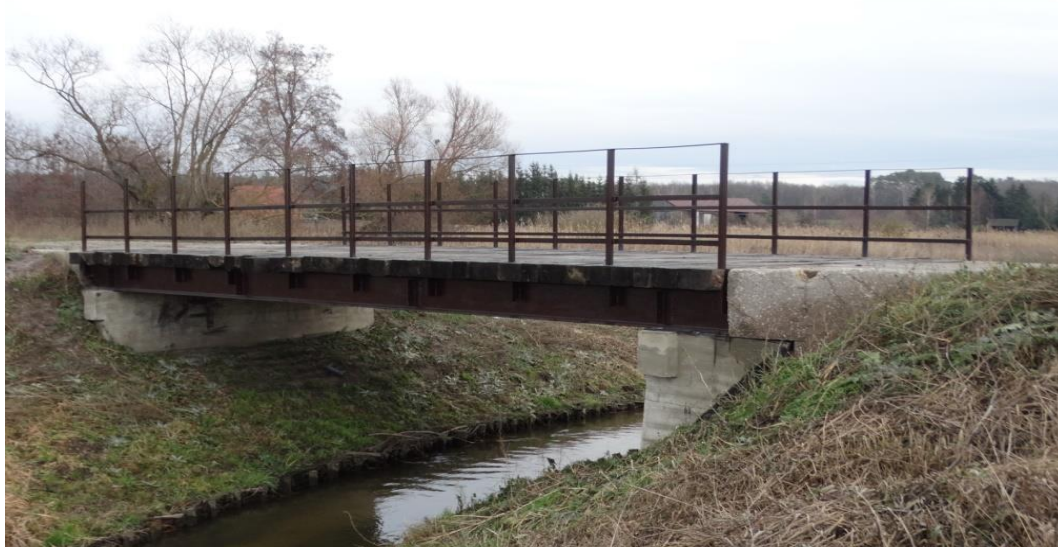
Zmodernizowany most na Welniance w Busieńcu.
