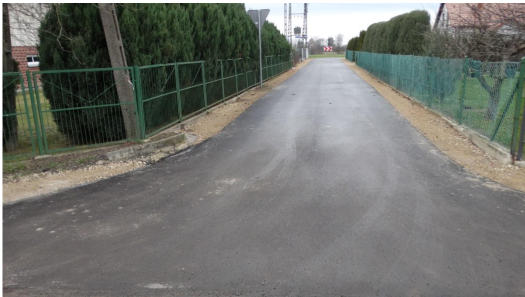
Zmodernizowane drogi na Osiedlu w Białopolu.
