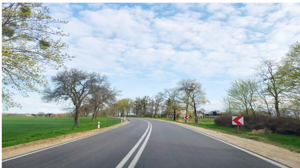
Przebudowana droga wojewódzka w Raciborowicach.
