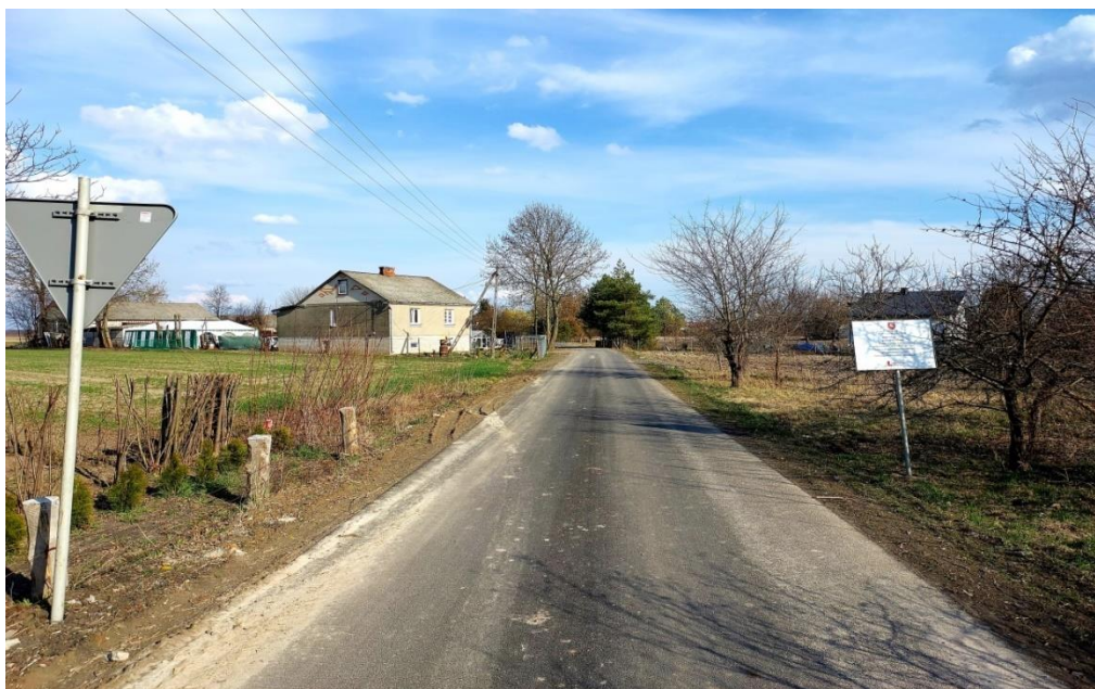
Zmodernizowana droga gminna w Białopolu.
