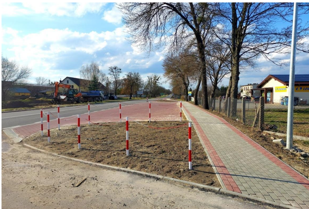
Wybudowany chodnik przy drodze wojewódzkiej w Buśnie.
