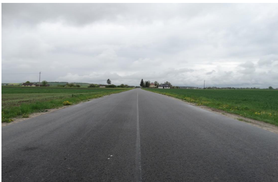
Zmodernizowana droga powiatowa Białopole – Teresin
