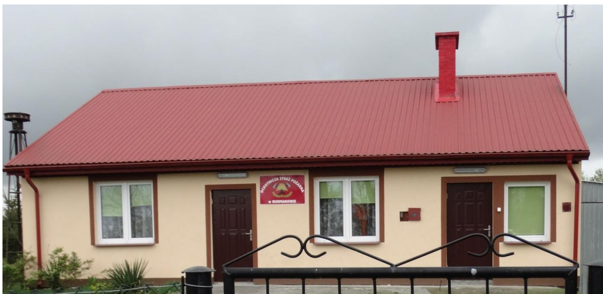
Termomodernizacja remizo - świetlicy w Kurmanowie.
