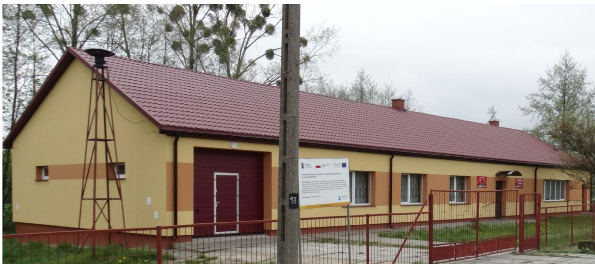
Termomodernizacja remizo - świetlicy w Raciborowicach Kolonii
