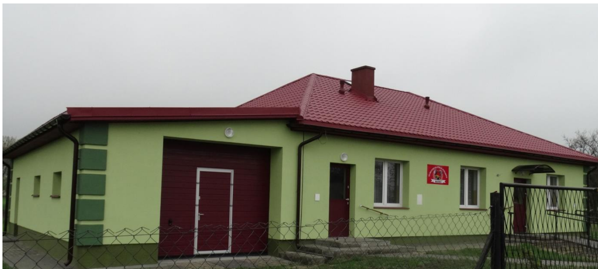
Termomodernizacja remizo - świetlicy w Buśnie
