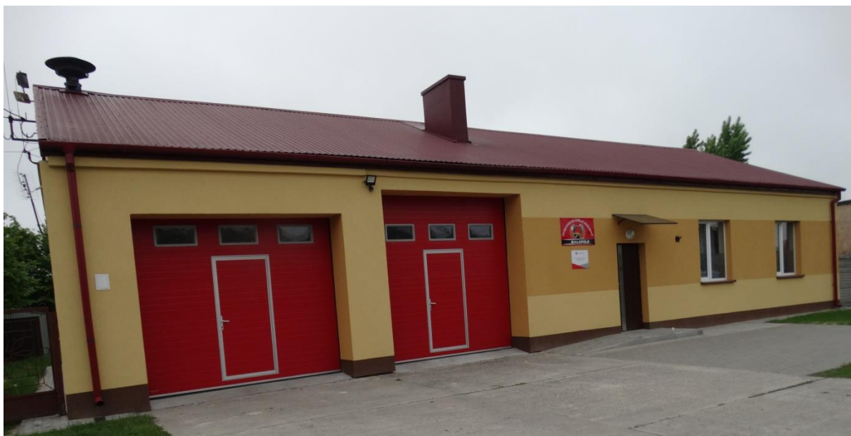
Termomodernizacja remizo - świetlicy w Białopolu
